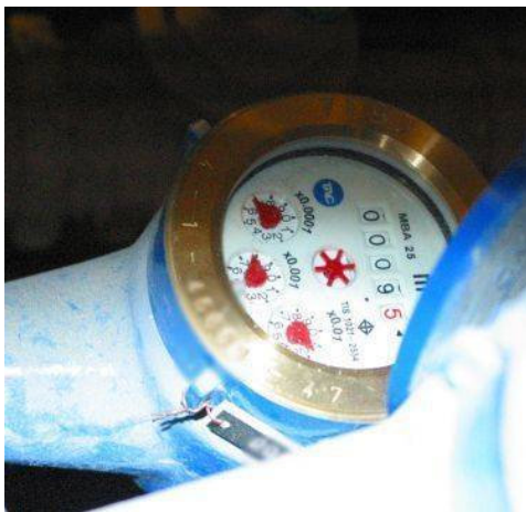
รูปภาพที่ 11 มิเตอร์น้ำที่ต้องตรวจสอบว่าวิ่งหรือไม่ถ้าไม่มีการใช้งานน้ำภายในบ้าน
