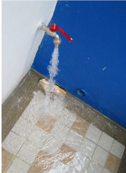
รูปภาพที่ 13 เปิดน้ำเพื่อขังน้ำไว้เพื่อการตรวจสอบและการใช้เศษผ้าเพื่ออุดช่องระบายน้ำบริเวณที่ไม่มีลูกบิดน้ำ
