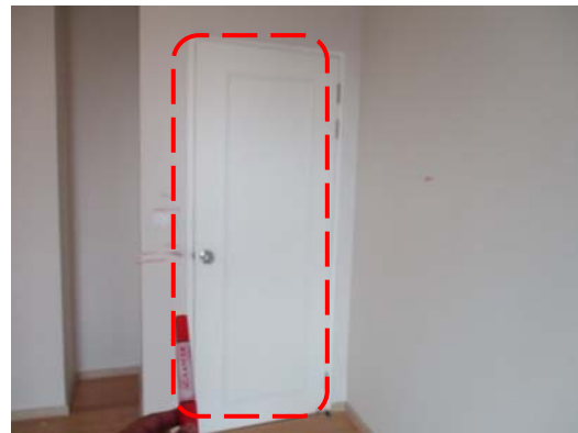
Pic:12ห้องนอนใหญ่ เซาะร่องรอบวงกบไม่เรียบ ขอบแตกรอบ ควร โป้ว ขัดแต่ง เซาะร่องให้เรียบ รอบวงกบ
