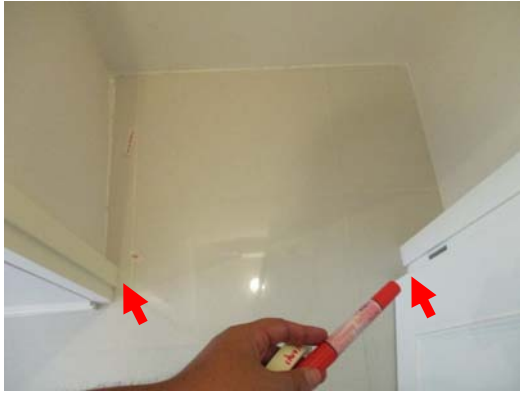
Pic:13 ห้องเก็บของ ซิลิโคนตีนวงกบไม่เรียบ ทุกจุด ควรเก็บซิลิโคนใหม่ทั้งหมด
