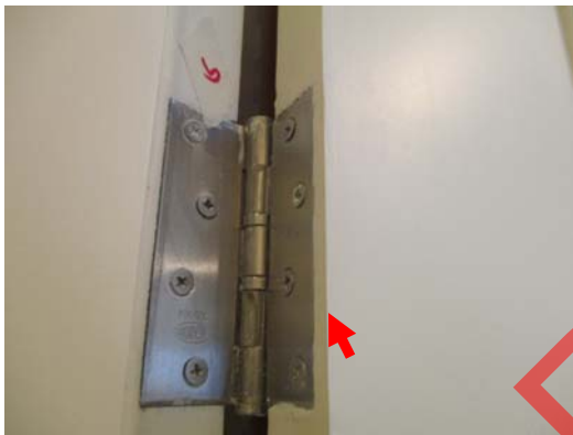
Pic:15 ห้องเก็บของ ขอบบานพับไม่เรียบ มีร่องห่าง ทุกจุด ควรโป้ว ชัดให้เรียบ ทาสีใหม่
