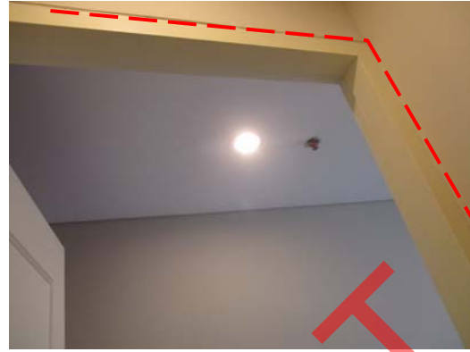
Pic:14 ห้องเก็บของ เซาะร่องรอบวงกบไม่เรียบ ขอบแตก รอบ ควร โป้ว ชัดแต่ง เซาะร่องให้เรียบ รอบวงกบ
