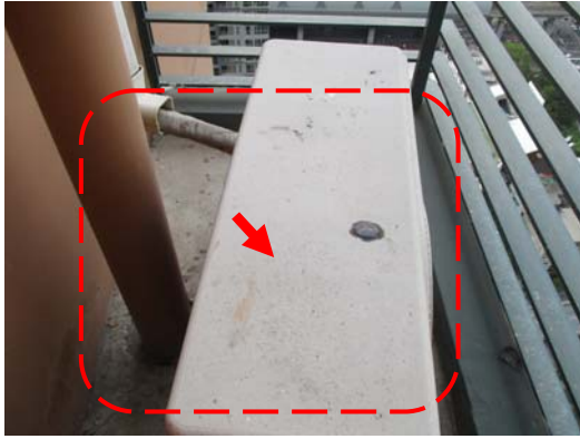
Pic:13 ห้องน้ำห้องนอนใหญ่ พื้นและ ทั่ว มีจีปูน ควรทำความสะอาด แล คอมแอร์ วางเอียง ควรแก้ไข
