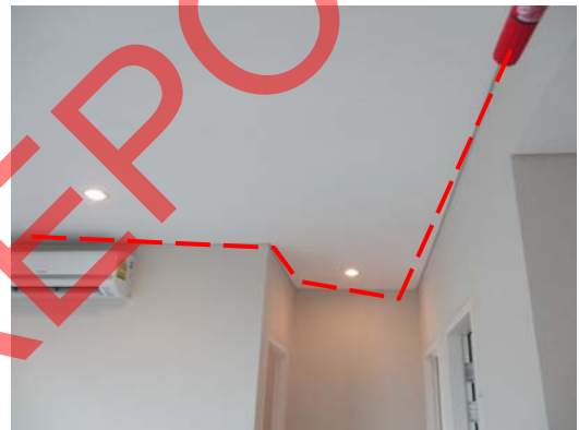
Pic:10 รับแขก ขอบฝ้าแตกรอบห้อง ฝ้าไม่เรียบ สีต่างรอบ ควร โป้ว ชัดให้เรียบ ทาสีใหม่ทั้งห้อง
