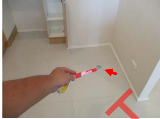
Pic:20 คริ้ว กระเบื้องบัน 1 แผ่น ควรเปลี่ยน (เทียบสีให้เหมือนก่อนเปลี่ยน)
