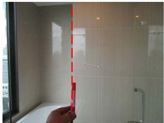
Pic:24 ห้องน้ำห้องนอนใหญ่ ขอบกระเบื้อง คมทั้งแนว ควร ลบคมขอบกระเบื้อง
