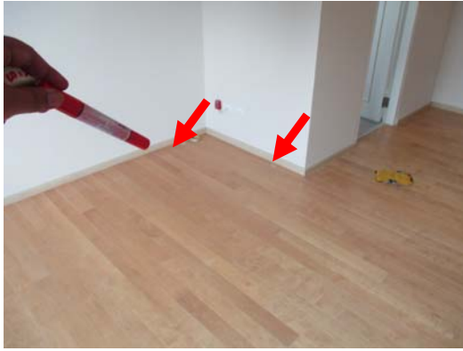
Pic:7 ห้องนอนใหญ่ พื้นไม้ตามภาพขุบ ควรแก้ไขอัดลิ้ม เก็บซิลิโคนขอบให้เรียบร้อย
