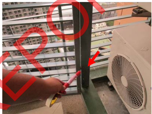
Pic:22 รับแขก-ระเบียง ขอบ เหล็ก มีรูเจาะบานพับผิด ควรแก้ไข ทั้งหมด
