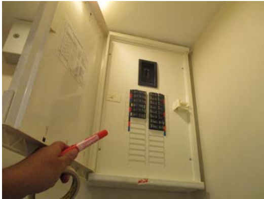
Pic:1 ตู้เบรกเกอร์ ไม่สามารถเปิดดู ขนาดสายไฟและ ความเรียบร้อยภายในตู้ได้
