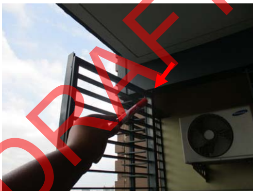
Pic:23 รับแขก-ระเบียง มุมบานประตู มีร่องห่าง ควร โป้วปิดร่อง ให้เรียบ เก็บสีใหม่
