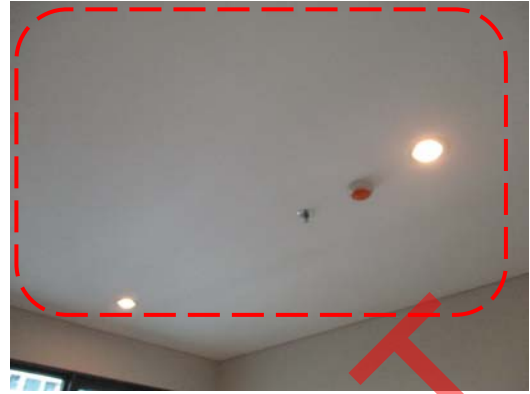
Pic:20 ห้องนอน 2 ขอบฝ้าแตกรอบห้อง ฝ้าไม่เรียบ สีด่างรอบ ควรโป้ว ขัดให้เรียบ ทาสีใหม่ทั้งห้อง
