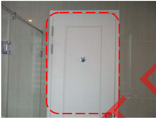
Pic:9 ห้องน้ำห้องนอนใหญ่ ขาแนวแตกรอบวงกบ ควร เก็บ ขาแนวใหม่รอบวงกบ
