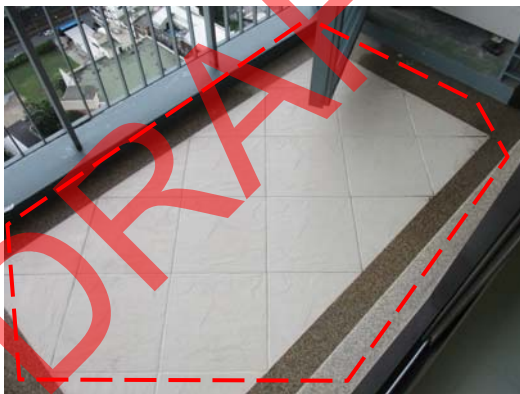
Pic:11 รับแขก-ระเบียง พื้นทรายล้างและคราบทั่ว ควรทำความสะอาดด้วยกรดเกลือ และขานแนวเก่า ควรขานแนวใหม่
