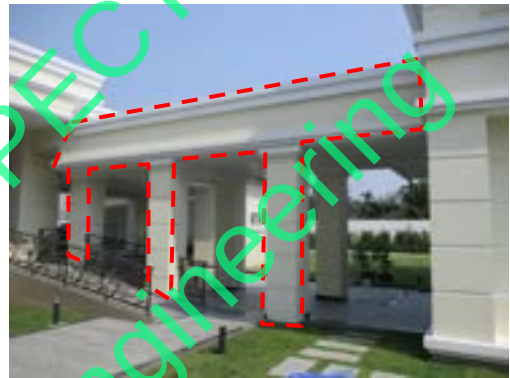
Pic:28 ผนังไม่เรียบ สีต่างทั่ว กับบัวปูนไม่เรียบ บัน รอยต่อแตก ควรโป้ว ชัด เก็บสีใหม่ทั้งแผง และเจาะร่องผนังไม่เรียบ ควรโป้ว ชัด เก็บสีใหม่ทั้งหมด
