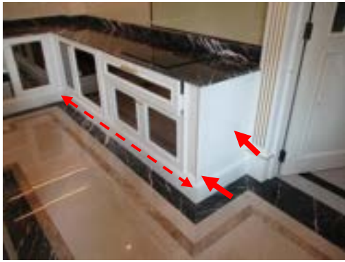
Pic:43 บิวท์เลอะคราบ กับบัวพื้น สีต่าง ควรเก็บสีใหม่
