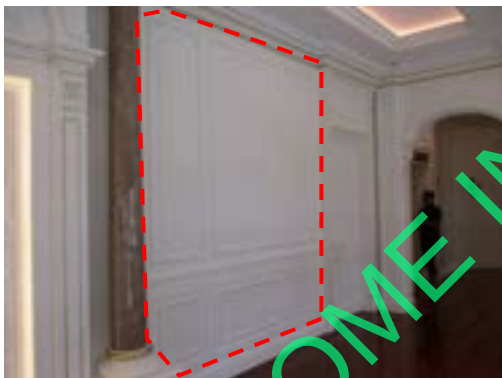
Pic:9 รอยต่อบัวที่ไม่เรียบ ขอบแตก ควรโป้ว ชัดเก็บสีใหม่ และซึลโคนขอบบัวที่ไม่เรียบ ควรเก็บซึลโคนใหม่
