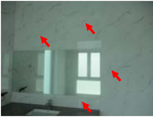
Pic:13 กระเบื้องร้อน โพรง 4 แผ่น ควรแก้ไขลอกยกยาแนวหยอดน้ำปูนเกร้าท์ (ถ้าไม่หาย ควรเปลี่ยนใหม่ให้เรียบร้อย)
