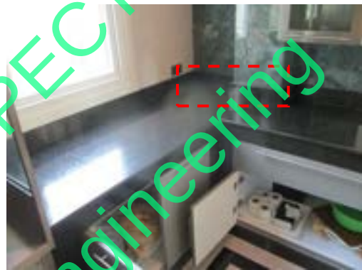
Pic:22 ยาน้ำขอบกระเบื้องไม่เรียบ ควรเก็บยาน้ำใหม่
