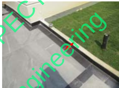
Pic:10 กระเบื้องร้อน โพรง 1 แผ่น ควรแก้ไขลอกยกยาแนวหยุดน้ำปูนเกร้าท์ หรือเปลี่ยนใหม่
