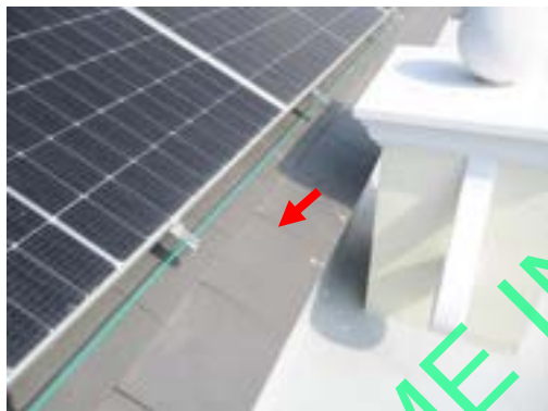
Pic:21 ขอบแผ่นหลังคาบิน ควรโป้วแต่งสีใหม่ (เทียบสีก่อน แต่งสี)
