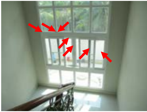
Pic:13 กรอบบานเลื่อนเป็นรอย ควรโป้ว ชัดแต่งสีใหม่ และ กระจกเป็นรอย ควรเปลี่ยนใหม่ และมูมรอยต่อฝาปิดขอบ กระจกไม่แนบ ควรติดตั้งใหม่
