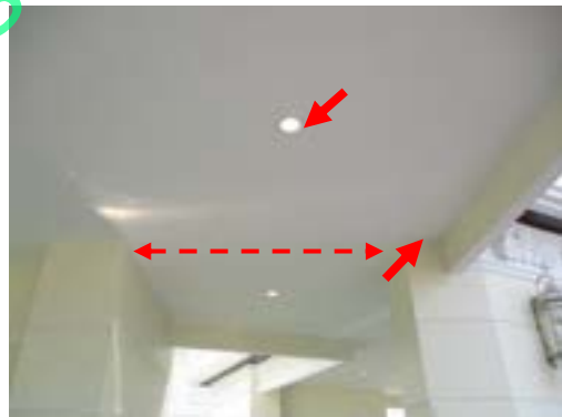
Pic:30 ขอบฝ้า กับรอยต่อฝ้าแตก ควรโป้ว ชัด เก็บสีใหม่ และฝ้าข้างโคมไฟแตก ควรโป้ว ชัด เก็บสีใหม่
