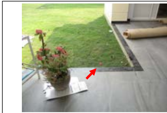
Pic:13 กระเบื้องร้อน โพรง 1 แผ่น ควรแก้ไขลอกยกยาแนวหยุดน้ำปูนเกร้าท์ หรือเปลี่ยนใหม่
