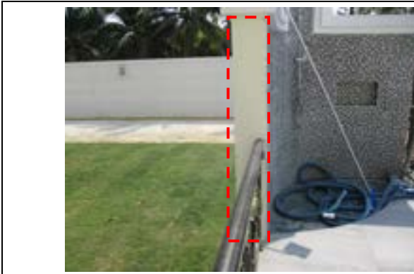
Pic:97 ผนังไม่เรียบ สีต่าง ควรโป้ว ชัด เก็บสีใหม่
