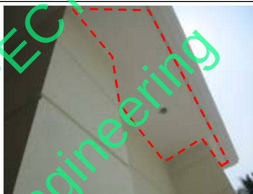
Pic:34 ขอบฟ้าไม่เรียบ สีต่าง ควรโป้ว ชัด เก็บสีใหม่
