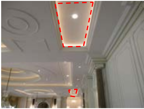
Pic:25 ขอบฝ้าสีต่าง ควรเก็บสีใหม่
