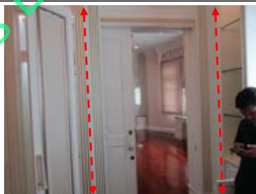
Pic:30 ซิลิโคนขอบบิวท์ไม้เรียบ ควรเก็บซิลิโคนใหม่
