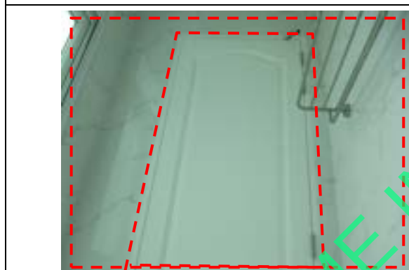
Pic:27 ยาแนวขอบวงกบไม่เรียบ ควรเก็บยาแนวใหม่ และวงกบสีต่าง ควรเก็บสีใหม่ และผนังเลอะคราบ และยาแนวไม่เรียบ เลอะคราบทั่ว ควรเก็บยาแนวใหม่ และทำความสะอาดใหม่ทั้งหมด
