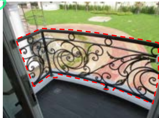
Pic:36 ห้องนอน 2 ราวเหล็ก สีด่าง สีถลอก เป็นสนิม ควรขัด เก็บสีใหม่
