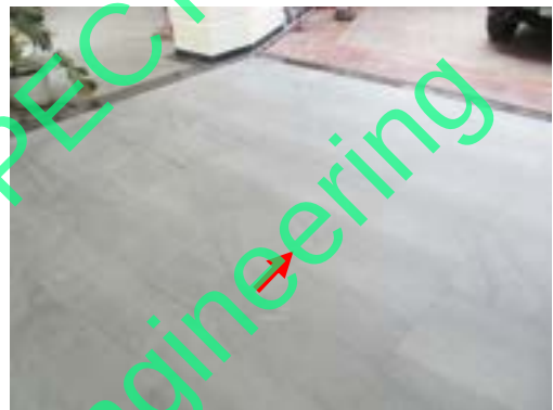
Pic:16 กระเบื้องร้อน โพรง 1 แผ่น ควรแก้ไขลอกยกยาแนวหยุดน้ำปูนเกร้าท์ หรือเปลี่ยนใหม่
