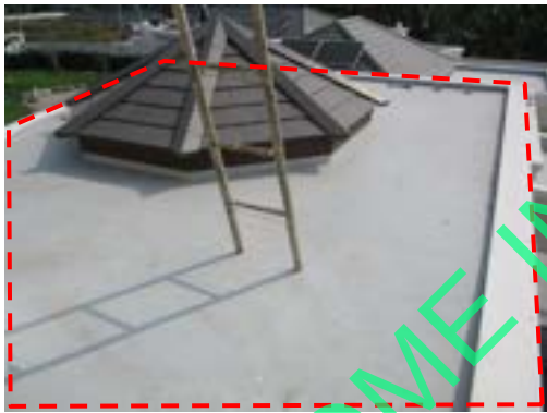
Pic:39 ขอบปูนมีรอยร้าว ไม่เรียบ สีต่าง ควรโป้ว ชัด เก็บสีใหม่ และพื้นเลอะคราบ ควรทำความสะอาด ถ้าไม่หายควรเก็บสีใหม่ทั้งหมด
