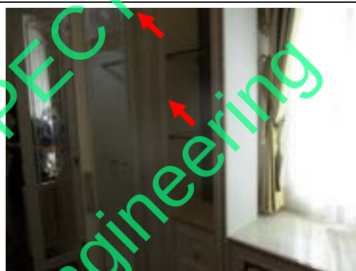
Pic:28 บิวท์สีใหม่เรียบ กับรอยต่อแตก ควรขัดเก็บสีใหม่
