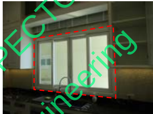
Pic:46 ซิลิโคนขอบไวน์ลิไม่เรียบ ควรเก็บซิลิโคนใหม่
