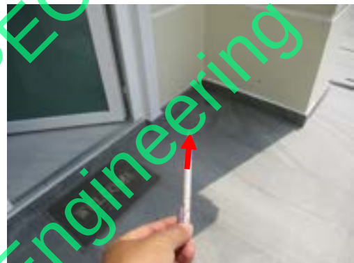
Pic:76 กระเบื้องร่อน โพรง 1 แผ่น ควรแก้ไขลอกยาแนว หยอดน้ำปูนเกร้าท์ (ถ้าไม่หาย ควรเปลี่ยนใหม่ให้เรียบร้อย)
