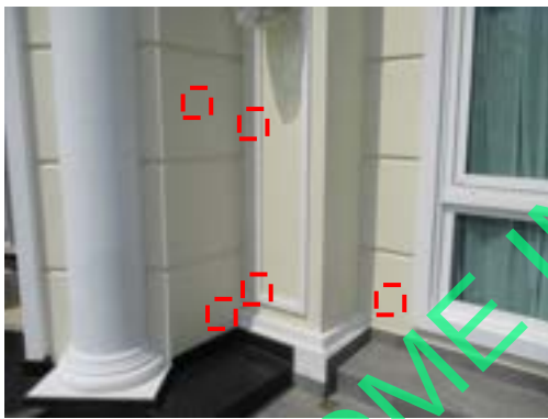
Pic:39 ผนังไม้เรียบ ครอบโป้ว ชัด เก็บสีใหม่
