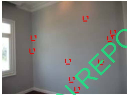
Pic:32 ห้องนอน 2 ผนังสีด่าง ไม่เรียบ ควรโป้ว ชัด เก็บสีใหม่
