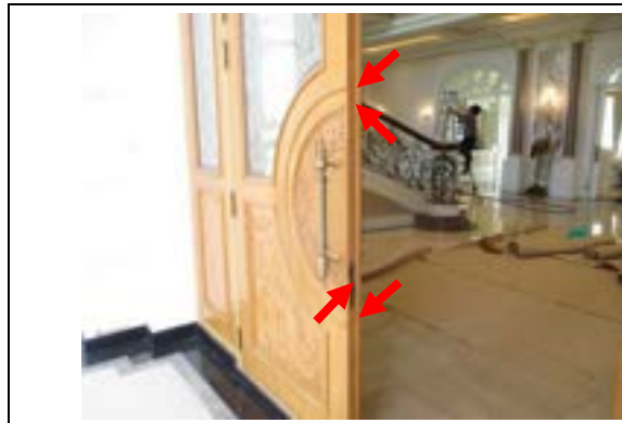
Pic:19 สันบานประตูเป็นรอย บุป ควรโป้ว ชัดแต่งสีใหม่ และ ขอบรอบแป้นลงเดือยมีร่อง แตก ควรโป้ว ชัดแต่งสีใหม่
