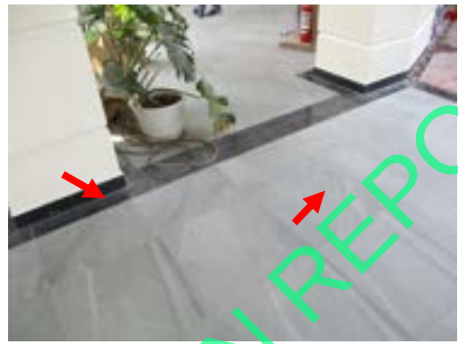
Pic:14 กระเบื้องร้อน โพรง 2 แผ่น ควรแก้ไขลอกยกยาแนวหยุดน้ำปูนเกร้าท์ หรือเปลี่ยนใหม่
