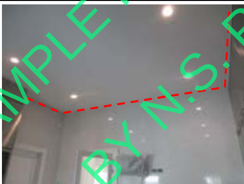
Pic:29 ขอบผ้าไม่เรียบ แตก ควรโป้ว ชัดเก็บสีใหม่
