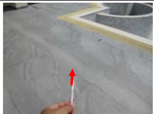
Pic:102 กระเบื้องร้อน โพรง 1 แผ่น ควรแก้ไขลอกยาแนวหยอดน้ำปูนเกร้าท์ (ถ้าไม่หาย ควรเปลี่ยนใหม่ให้เรียบร้อย)
