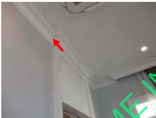
Pic:33 ห้องนอน 2 รอยต่อบัวฝ้า แตก ควรโป้ว ชัด เก็บสีใหม่
