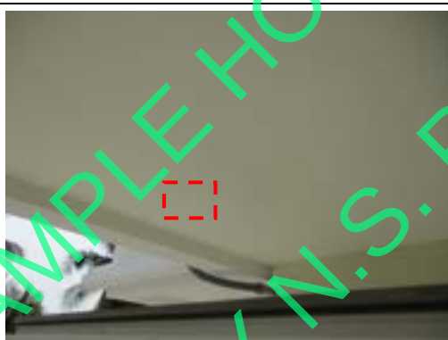
Pic:29 ฝ้าไม่เรียบ ควรโป้ว ชัด เก็บสีใหม่
