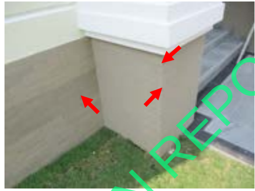
Pic:26 ขอบแผ่นอิฐประดับบัน ควรเปลี่ยนใหม่ และรอยต่ออิฐประดับข้าง ควรแต่งปูนเก็บรอยต่อให้เรียบร้อย
