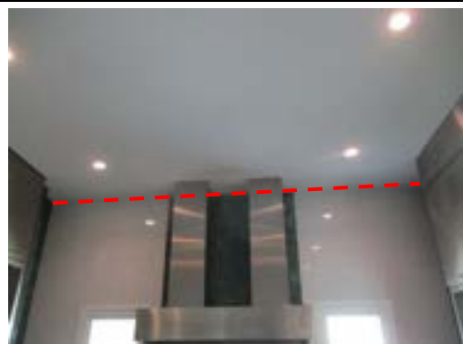
Pic:30 ขอบผ้าไม่เรียบ แตก ควรโป้ว ชัดเก็บสีใหม่
