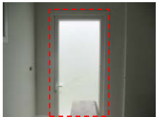
Pic:12 ขอบผนังรอบวงกบไม่เรียบ ควรโป้ว ชัด เก็บสีใหม่
