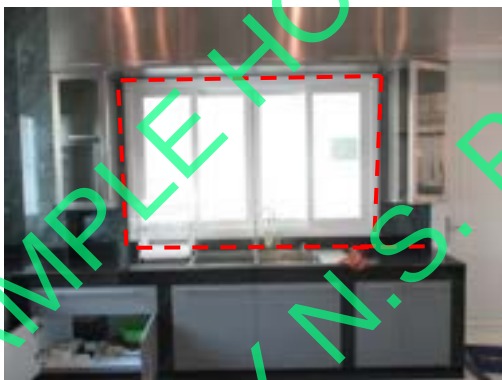
Pic:23 ไวนิลไม่เรียบ ควรไป ขัดเก็บสีใหม่
