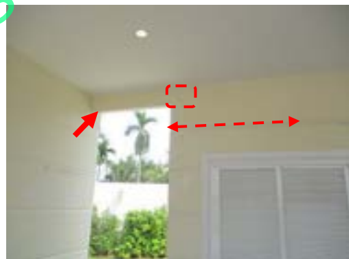
Pic:24 ผนัง กับขอบเสาเจาะร่องผนังร้าว ควรโป้ว ชัด เก็บสีใหม่ และท้องปูนไม่เรียบ ควรโป้ว ชัด เก็บสีใหม่
