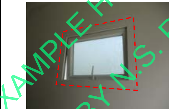
Pic:11 ขอบผนังรอบเฟรมไม่เรียบ ควรโป้ว ชัด เก็บสีใหม่
