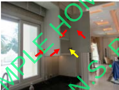
Pic:47 บิวท์ไม่เรียบ แตก เลอะคราบ ควรโป้ว ชัดเก็บสีใหม่ และบานพับเป็นสนิม ควรทำความสะอาด
