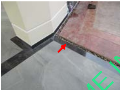
Pic:15 กระเบื้องร้อน โพรง 1 แผ่น ควรแก้ไขลอกยกยาแนวหยุดน้ำปูนเกร้าท์ หรือเปลี่ยนใหม่
