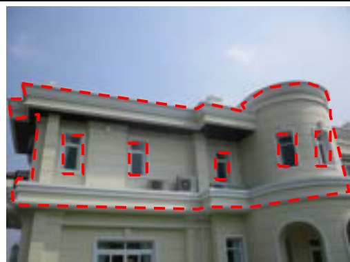
Pic:12 ผนังสีต่างทั่ว ควรเก็บสีใหม่ทั้งหมด และบัวปูนมีรอยร้าว สีต่าง ควรโป้ว ชัด เก็บสีใหม่ทั้งหมด และซิลิโคนขอบเฟรมไม้เรียบ ควรเก็บซิลิโคนใหม่รอบ
