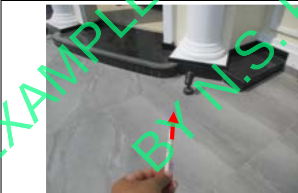
Pic:101 กระเบื้องร้อน โพรง 1 แผ่น ควรแก้ไขลอกยาแนวหยอดน้ำปูนเกร้าท์ (ถ้าไม่หาย ควรเปลี่ยนใหม่ให้เรียบร้อย)
