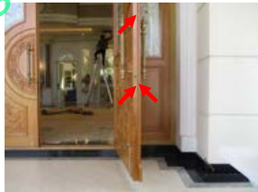
Pic:18 สันบานประตูเป็นรอย ควรชัดแต่งสีใหม่ และขอบรอบแป้นเดือยมีร่องแตก ควรโป้ว ชัดแต่งสีใหม่
