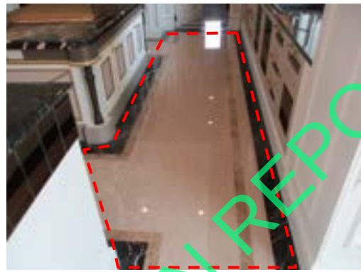
Pic:26 กระเบื้องร้อน โพรงทั้งผืน ควรแก้ไขลอกยาแนวหยอด น้ำปูนเกร้าท์ หรือเปลี่ยนใหม่เทียบสีก่อนเปลี่ยน
