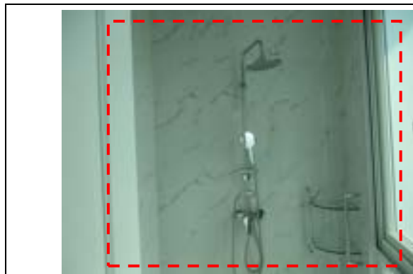
Pic:25 ผนังเลอะคราบ และยาแนวไม่เรียบ เลอะคราบทั่ว ควรเก็บยาแนวใหม่ และทำความสะอาดใหม่ทั้งหมด
