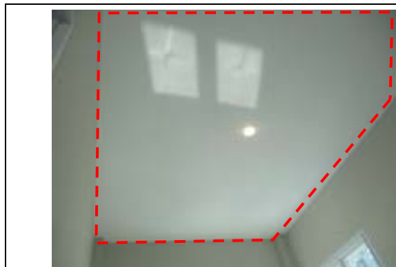
Pic:13 ฝ้าเพดานไม่เรียบ สีต่าง เลอะคราบ ครรไปว ชัดเก็บสีใหม่
