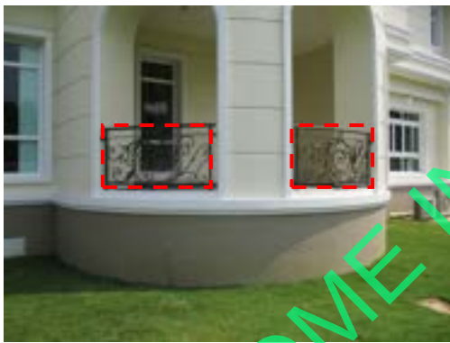
Pic:9 ราวเหล็กเป็นสนิมทั่ว ควรขัด เก็บสีใหม่ทั้งหมด
