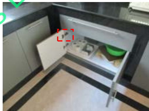
Pic:24 บานพับไม่แน่น ควรติดตั้งใหม่
