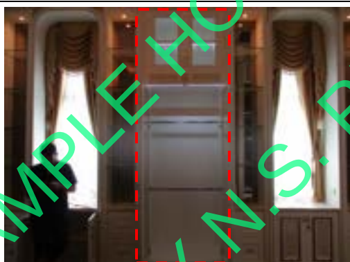
Pic:29 บิวท์ไม้เรียบ รอยต่อแตก เป็นรอย ควรโป้ว ชัดเก็บสีใหม่
