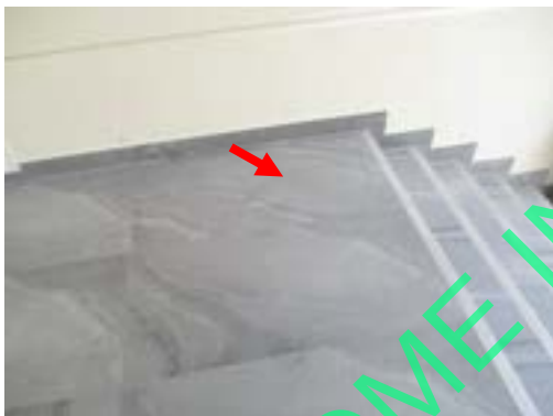
Pic:33 กระเบื้องร้อน โพรง 1 แผ่น ควรแก้ไขลอกยาแนวหยอดน้ำปูนเกร้าท์ หรือเปลี่ยนใหม่
