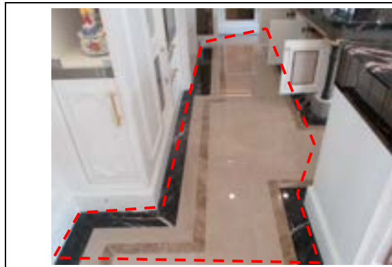
Pic:25 กระเบื้องร้อน โพรงทั้งผืน ควรแก้ไขลอกยาแนวหยอด น้ำปูนเกร้าท์ หรือเปลี่ยนใหม่เทียบสีก่อนเปลี่ยน
