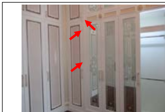
Pic:13 รอยต่อบิวท์แตก กับบิวท์เลอะคราบ ควรโป้ว ชัดเก็บสีใหม่
