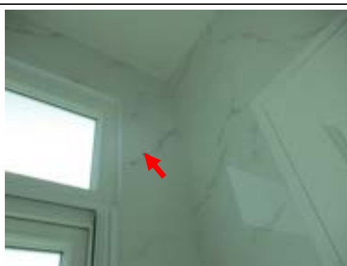
Pic:30 กระเบื้องร้อน โพรง 1 แผ่น ควรแก้ไขลอกยาแนวหยอดน้ำปูนเกร้าท์ (ถ้าไม่หาย ควรเปลี่ยนใหม่ให้เรียบร้อย)
