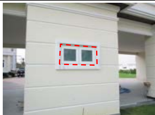
Pic:48 ไลน์ลอะคราบ มีเทปกาวติด ควรทำความสะอาดใหม่
