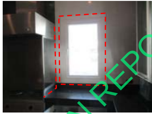
Pic:20 ซิลิโคนขอบไวน์ส กับขอบอลูมิเนียมไม่เรียบ ควรเก็บซิลิโคนใหม่ และไวน์สเลอะคราบ ควรทำความสะอาด
