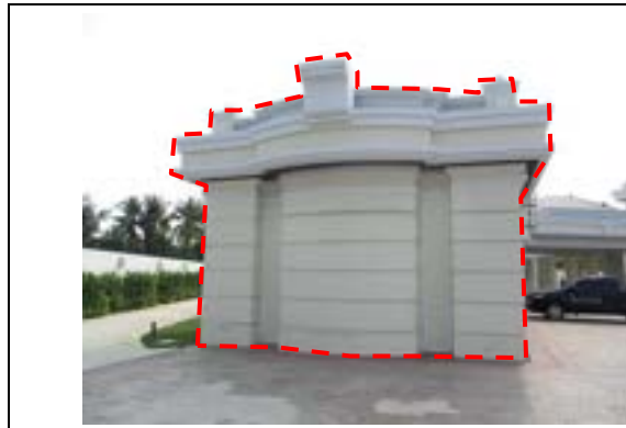
Pic:43 ผนังไม่เรียบ สีย้อย สีต่าง กับเขาะร่องผนังไม่เรียบ ควรโป้ว ชัด เก็บสีใหม่ทั้งหมด
