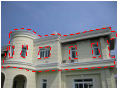
Pic:7 ผนังสีต่างทั่ว ควรเก็บสีใหม่ทั้งหมด และบัวปูนมีรอยร้าว สีต่าง ควรโป้ว ชัด เก็บสีใหม่ทั้งหมด และซิลิโคนขอบเฟรมไม้เรียบ ควรเก็บซิลิโคนใหม่รอบ
