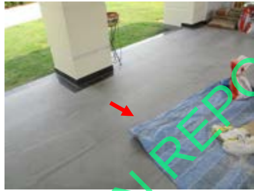
Pic:20 กระเบื้องร่อน โพรง 2 แผ่น ควรแก้ไขลอกยกยาแนวหยุดน้ำปูนเกร้าท์ หรือเปลี่ยนใหม่
