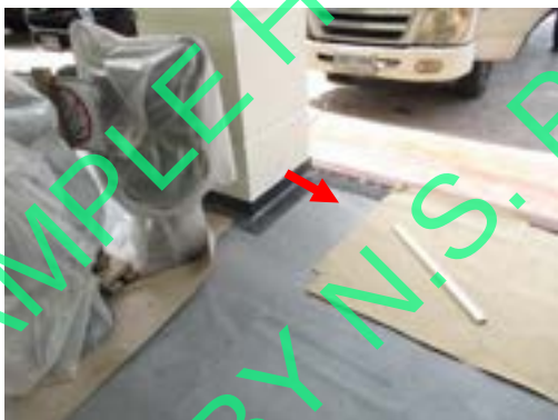
Pic:23 กระเบื้องร่อน โพรง 1 แผ่น ควรแก้ไขลอกยกยาแนวหยุดน้ำปูนเกร้าท์ หรือเปลี่ยนใหม่
