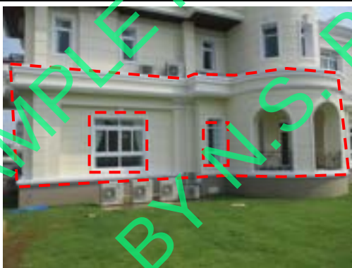
Pic:11 ผนังไม้เรียบ สีย้อย สีต่าง เลอะคราบทั่ว ควรโป้ว ชัด เก็บสีใหม่ทั้งหมด และบัวปูนมีรอยร้าว สีต่าง ควรโป้ว ชัด เก็บสีใหม่ทั้งหมด และซิลิโคนขอบเฟรมไม้เรียบ ควรเก็บซิลิโคนใหม่รอบ
