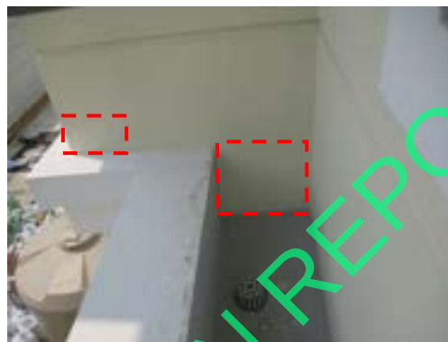
Pic:26 ผนังไม่เรียบ ควรโป้ว ชัด เก็บสีใหม่
