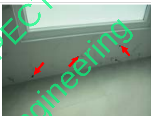
Pic:28 กระเบื้องร้อน โพรง 3 แผ่น ควรแก้ไขลอกยาแนวหยอดน้ำปูนเกร้าท์ (ถ้าไม่หาย ควรเปลี่ยนใหม่ให้เรียบร้อย)
