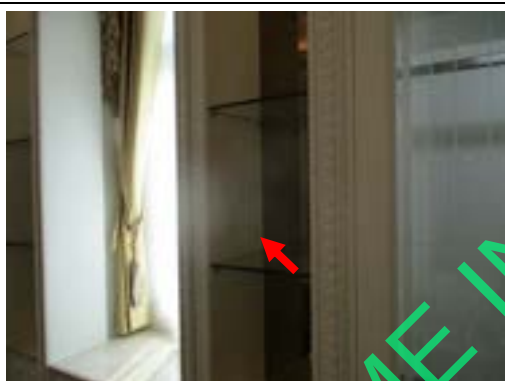
Pic:27 นอตยึดบิวท์จม ควรติดตั้งใหม่
