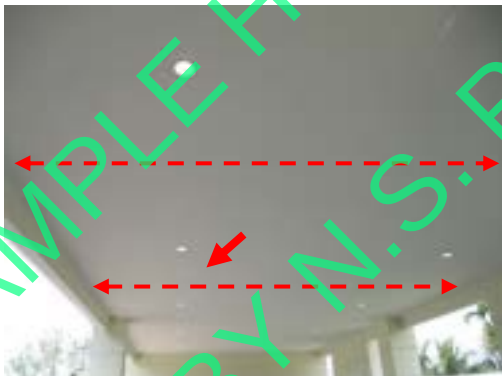
Pic:29 ฝ้าไม่เรียบ มีสีพอง กับรอยต่อฝ้าแตก ควรโป้ว ชัด เก็บสีใหม่
