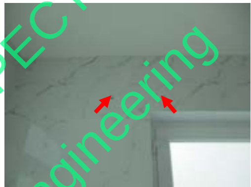
Pic:16 กระเบื้องร้อน โพรง 2 แผ่น ควรแก้ไขลอกยกยาแนวหยอดน้ำปูนเกร้าท์ (ถ้าไม่หาย ควรเปลี่ยนใหม่ให้เรียบร้อย)
