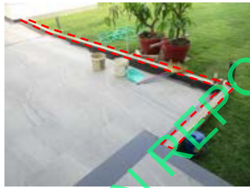
Pic:8 ขอบปูนมีรอยร้าว เลอะคราบ ควรโป้ว ชัด เก็บสีใหม่
