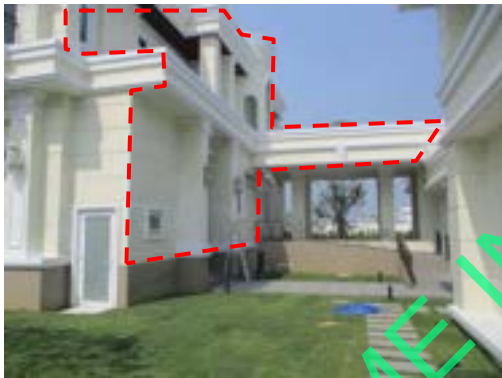
Pic:27 ผนังไม่เรียบ สีต่างทั่ว กับบัวปูนไม่เรียบ บัน รอยต่อแตก ควรโป้ว ชัด เก็บสีใหม่ทั้งแผง และเจาะร่องผนังไม่เรียบ ควรโป้ว ชัด เก็บสีใหม่ทั้งหมด
