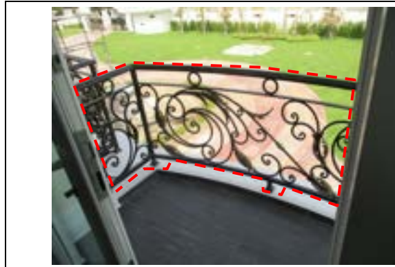
Pic:37 หอมนอน 2 ราวเหล็ก สีดำ สีสลัก เป็นสนิม ควรขัดเก็บสีใหม่
