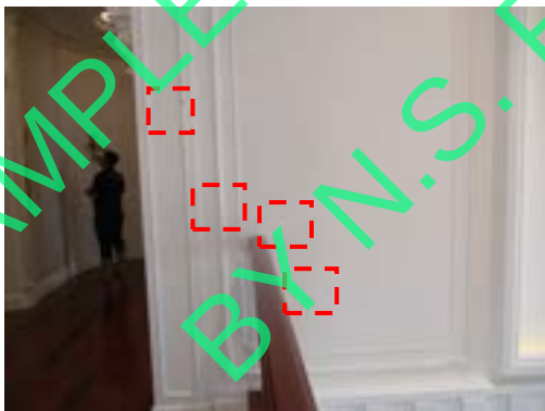
Pic:11 บัวที่ไม่เรียบ เลอะคราบ ควรโป้ว ชัดเก็บสีใหม่
