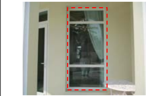
Pic:73 ซิลิโคนขอบเฟรมไม่เรียบ ควรเก็บซิลิโคนใหม่รอบ
