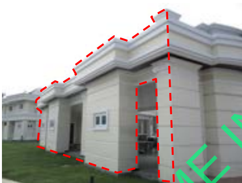
Pic:45 ผนังไม่เรียบ สีย้อย สีต่าง กับเขาะร่องผนังไม่เรียบ สีต่าง ควรโป้ว ชัด เก็บสีใหม่ทั้งหมด และบัวปูนไม่เรียบ รอยต่อแตกทั่ว ควรโป้ว ชัด เก็บสีใหม่
