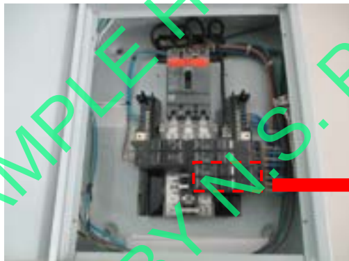
Pic:11 เบรกเกอร์ควบคุมน้ำอุ่นห้องน้ำแม่บ้านชั้น 1 และ 2 มีขนาด 32 A แต่ใช้สายไฟขนาด 1 x 4 ซึ่งมีขนาดไม่สัมพันธ์กัน ควรตรวจสอบตารางโหลดไฟฟ้าใหม่ เพื่อความปลอดภัย
