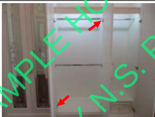
Pic:17 บานพับเป็นสนิม ควรขัดทำความสะอาด
