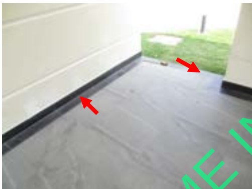
Pic:21 กระเบื้องร่อน โพรง 2 แผ่น ควรแก้ไขลอกยกยาแนวหยุดน้ำปูนเกร้าท์ หรือเปลี่ยนใหม่
