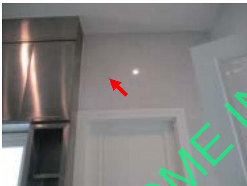
Pic:27 กระเบื้องร้อน โพรง 1 แผ่น ควรแก้ไขลอกยกยานวหยอด น้ำปูนเกร้าท์ หรือเปลี่ยนใหม่เทียบสีก่อนเปลี่ยน
