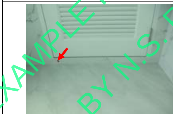
Pic:29 กระเบื้องร้อน โพรง 1 แผ่น ควรแก้ไขลอกยาแนวหยอดน้ำปูนเกร้าท์ (ถ้าไม่หาย ควรเปลี่ยนใหม่ให้เรียบร้อย)
