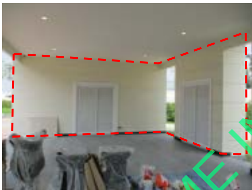
Pic:27 ผนังไม่เรียบ สีย้อย สีต่าง กับเขาห้องผนังไม่เรียบ ควรโป้ว ชัด เก็บสีใหม่ทั้งหมด
