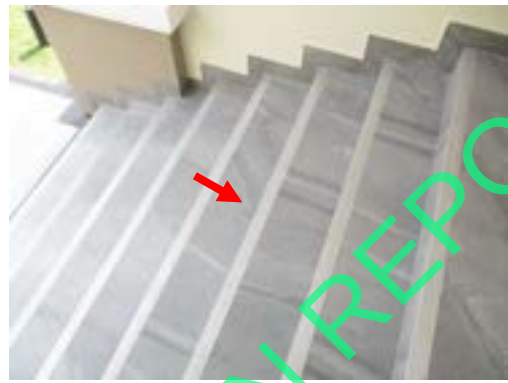
Pic:32 กระเบื้องร้อน โพรง 1 แผ่น ควรแก้ไขลอกยาแนวหยอดน้ำปูนเกร้าท์ หรือเปลี่ยนใหม่
