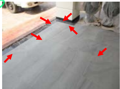
Pic:18 กระเบื้องร้อน โพรง 6 แผ่น ควรแก้ไขลอกยกยาแนวหยุดน้ำปูนเกร้าท์ หรือเปลี่ยนใหม่
