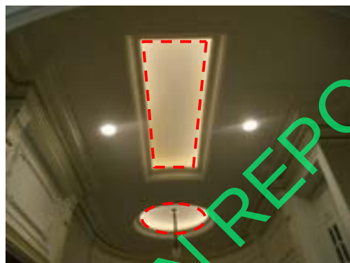
Pic:26 ขอบฝ้าสีต่าง ควรเก็บสีใหม่
