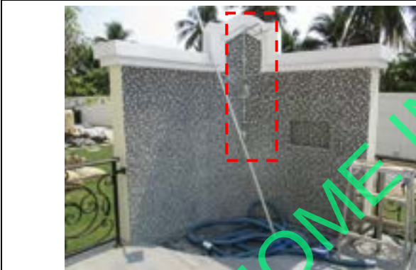
Pic:99 ชุดฝักบัวเป็นสนิม เป็นรอย ควรทำความสะอาดใหม่ (ถ้าไม่หาย ควรเปลี่ยนใหม่)
