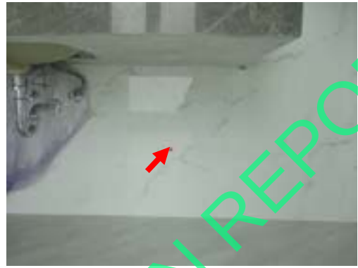
Pic:14 กระเบื้องร้อน โพรง 1 แผ่น ควรแก้ไขลอกยกยาแนวหยอดน้ำปูนเกร้าท์ (ถ้าไม่หาย ควรเปลี่ยนใหม่ให้เรียบร้อย)
