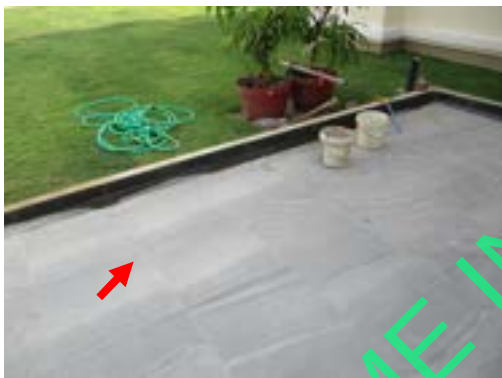
Pic:9 กระเบื้องร้อน โพรง 1 แผ่น ควรแก้ไขลอกยกยาแนวหยุดน้ำปูนเกร้าท์ หรือเปลี่ยนใหม่
