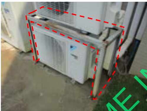
Pic:15 โครงเหล็กวางคอมเพรสเซอร์แอร์เป็นสนิมทั่ว ควรขัด เก็บสีใหม่ทั้งหมด
