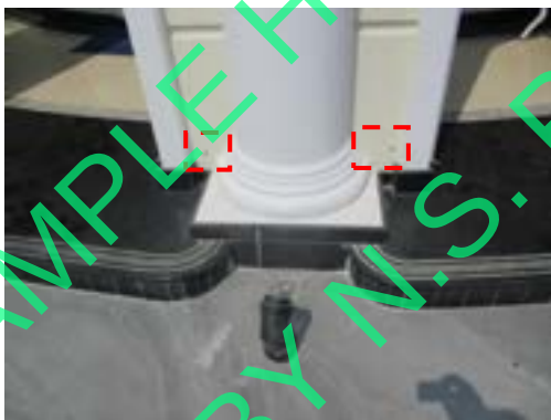
Pic:41 ผนังไม้เรียบ ครอบโป้ว ชัด เก็บสีใหม่
