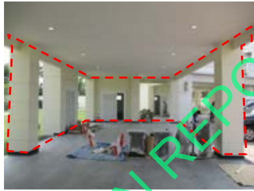
Pic:26 ผนังไม่เรียบ สีย้อย สีต่าง กับเขาห้องผนังไม่เรียบ ควรโป้ว ชัด เก็บสีใหม่ทั้งหมด
