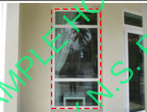
Pic:71 ซิลิโคนขอบเฟรมไม่เรียบ ควรเก็บซิลิโคนใหม่รอบ
