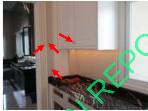
Pic:44 บิวท์ไม่เรียบ สีเป็นเม็ด สีต่าง ควรโป้ว ชัดเก็บสีใหม่
