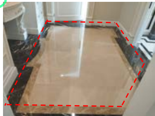
Pic:18 กระเบื้องร้อน โพรงหลายแผ่นตามภาพ ควรแก้ไขตามสต็อกเกอร์ ลอกยาแนวหยอดน้ำปูนเกร้าท์ หรือเปลี่ยนใหม่
