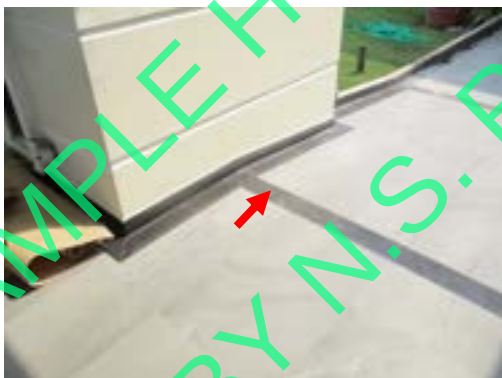
Pic:11 กระเบื้องร้อน โพรง 1 แผ่น ควรแก้ไขลอกยกยาแนวหยุดน้ำปูนเกร้าท์ หรือเปลี่ยนใหม่
