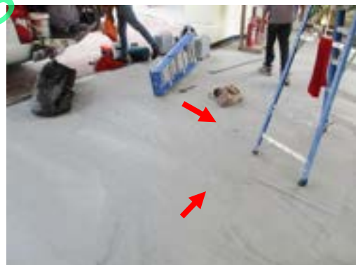
Pic:12 กระเบื้องร้อน โพรง 2 แผ่น ควรแก้ไขลอกยกยาแนวหยุดน้ำปูนเกร้าท์ หรือเปลี่ยนใหม่
