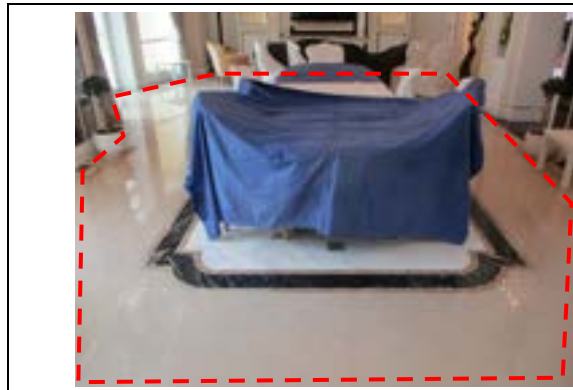
Pic:13 กระเบื้องร้อน โพรงทั้งผืน ควรแก้ไขลอกยาแนวหยอด น้ำปูนเกร้าท์ หรือเปลี่ยนใหม่เทียบสีก่อนเปลี่ยน
