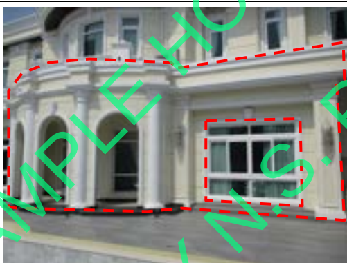
Pic:35 ผนังมีรอยโป้วเก็บงาน ไม่เรียบ สีต่าง เลอะคราบ กับบัวปูน มีรอยร้าว สีต่าง ควรโป้ว ชัด เก็บสีใหม่ทั้งหมด และซิลิโคนขอบ เฟอร์นิเจอร์ ควรเก็บซิลิโคนใหม่รอบ
