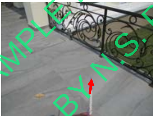
Pic:77 กระเบื้องร่อน โพรง 1 แผ่น ควรแก้ไขลอกยาแนวหยอดน้ำ ปูนเกร้าท์ (ถ้าไม่หาย ควรเปลี่ยนใหม่ให้เรียบร้อย)
