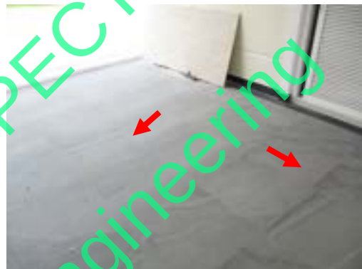
Pic:22 กระเบื้องร่อน โพรง 2 แผ่น ควรแก้ไขลอกยกยาแนวหยุดน้ำปูนเกร้าท์ หรือเปลี่ยนใหม่
