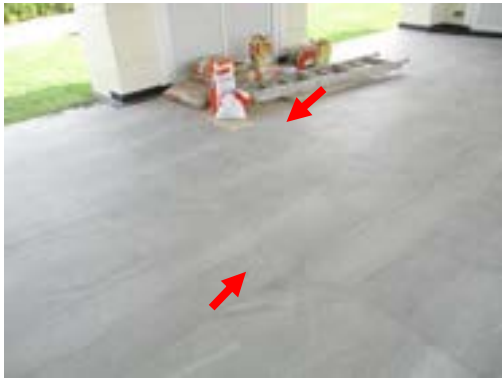
Pic:19 กระเบื้องร่อน โพรง 2 แผ่น ควรแก้ไขลอกยกยาแนวหยุดน้ำปูนเกร้าท์ หรือเปลี่ยนใหม่
