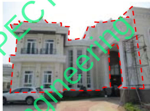
Pic:22 ผนังไม่เรียบ มีรอยร้าว สีต่างทั่ว กับบัวปูนไม่เรียบ บัน รอยต่อแตก ควรโป้ว ชัด เก็บสีใหม่ทั้งแผง และเซาะร่อง ผนังไม่เรียบ ควรโป้ว ชัด เก็บสีใหม่ทั้งหมด
