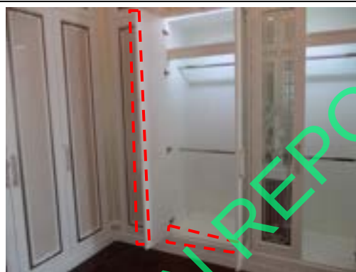
Pic:14 ขอบบานบิวท์ กับบิวท์สีต่าง ควรเก็บสีใหม่
