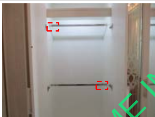
Pic:15 ราวแขวนผ้าเป็นสนิม ควรขัดทำความสะอาด
