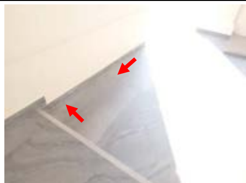
Pic:36 กระเบื้องร้อน โพรง 2 แผ่น ควรแก้ไขลอกยาแนวหยอดน้ำปูนเกร้าท์ หรือเปลี่ยนใหม่
