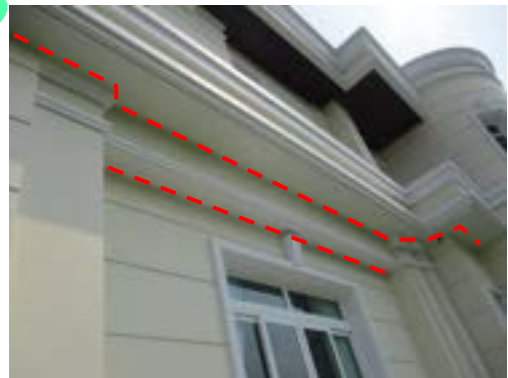
Pic:18 ขอบฝ้าไม่เรียบ สีต่าง ควรโป้ว ชัด เก็บสีใหม่
