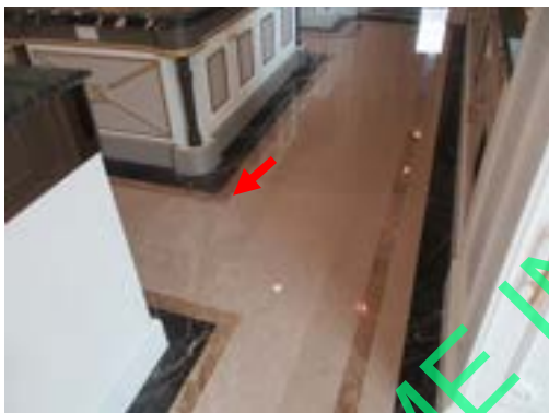
Pic:27 กระเบื้อง กระเด็ด 1 แผ่น ควร เก็บยาแนว (ถ้าไม่หาย ควรปูกระเบื้องใหม่)
