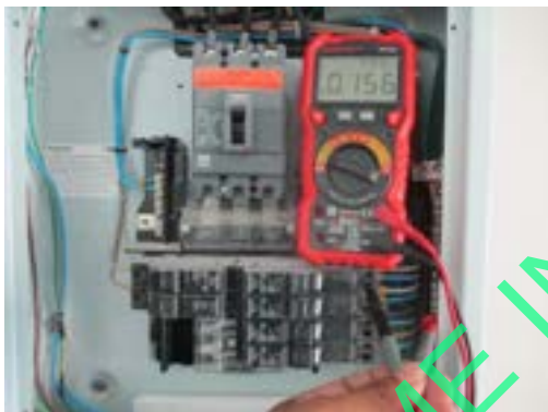
Pic:9 วัดกระแสระหว่างบาร์กราวด์ กับบาร์นิวทรัลไม่พบไฟรั่ว
