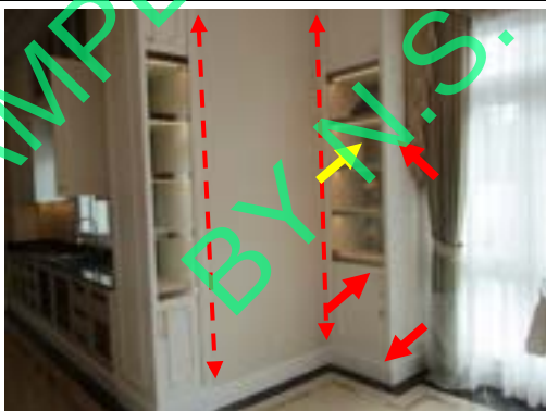
Pic:17 บิวท์ไม่เรียบ กับรอยต่อบิวท์แตก และผนังขอบบิวท์ไม่เรียบ แตก ควรโป้ว ชัดเก็บสีใหม่ และกระจกเป็นรอย ควรทำความสะอาดถ้าไม่หายควรเปลี่ยนใหม่
