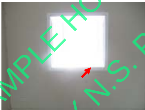
Pic:17 เฟรมไวนิลเป็นรอยขีด ควรแก้ไขเก็บงานเฟรมใหม่ให้ เรียบร้อย
