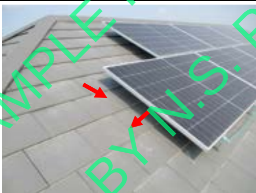
Pic:17 ขอบแผ่นหลังคาบิน กับแผ่นหลังคาเป็นรอย ควรโป้วแต่งสีใหม่ (เทียบสีก่อนแต่งสี)
