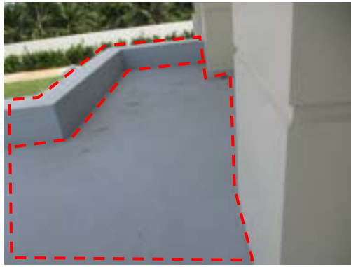
Pic:25 ขอบปูนร้าว สีต่าง เลอะคราบ ครรโป้ว ชัด เก็บสีใหม่ และพื้นเลอะคราบ สีต่าง ครรเก็บสีใหม่ทั้งหมด
