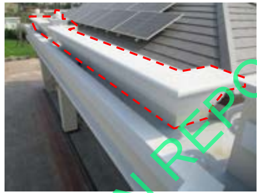
Pic:20 ผนัง กับบัวปูนไม่เรียบ มีรอยร้าว สีต่างทัว ควรโป้ว ชัด เก็บสีใหม่
