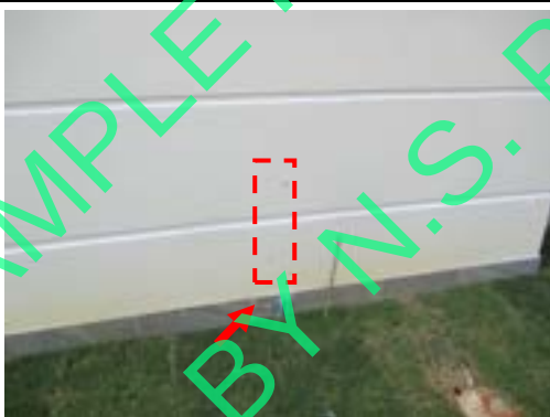
Pic:47 ผนังมีรอยร้าว ควรโป้ว ชัด เก็บสีใหม่ และกระเบื้องกระเด็น 1 แผ่น ควรเก็บยาแนว (ถ้าไม่หาย ควรปูกระเบื้องใหม่)
