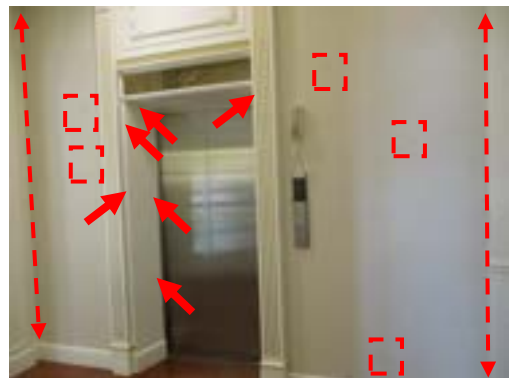
Pic:12 มุมผนัง กับผนังไม่เรียบ สีต่าง และบัวที่ไม่เรียบ ควร โป้ว ชัดเก็บสีใหม่
