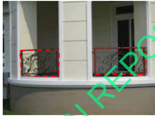
Pic:8 ราวเหล็กเป็นสนิมทั่ว ควรขัด เก็บสีใหม่ทั้งหมด
