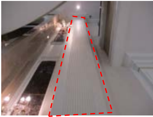
Pic:49 โถงทางเข้า บิวท์ เลอะคราบ ควรทำความสะอาดใหม่
