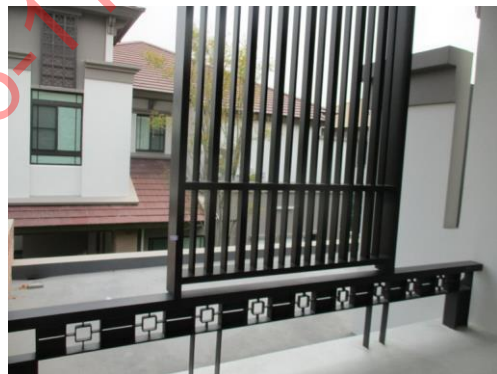
Pic:36 ระเบียงห้องนอน 1 ระแนงเหล็กมีคราบทั่ว ควรทำความสะอาดให้เรียบร้อย
