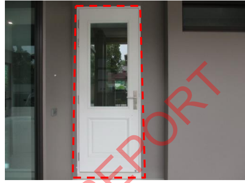
Pic:26 บานประตูมีกรอบทั่ว วงกบสี่ด้าน และขอบแตกกรอบ ควรไขว้แต่งขอบ เก็บสี และทำความสะอาด
