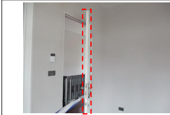
Pic:25 ห้องนอน 1 ขอบประตูสีต่าง ไม่เรียบ ควรขัดผิวให้เรียบ และทาสีเก็บให้เรียบร้อย ทุกบาน
