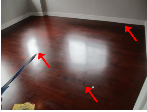
Pic:73 ห้องนอน 3 พื้นเป็นรอย ควรขัดเก็บสีใหม่
