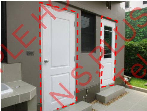
Pic:23 ช่างบ้าน ประตู วงกบสีต่าง ขอบแตกกรอบ ควรเก็บสี ใหม่ และเก็บขอบรอบวงกบให้เรียบร้อย
