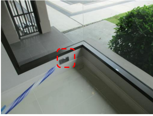
Pic:13 ห้องพักผ่อน เตำรับไม้แบบผนัง ควรติดตั้งให้เรียบร้อย
