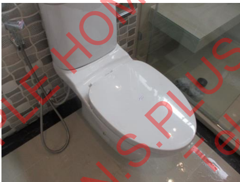
Pic:41 ห้องน้ำนอน 3 ฝารองนั่ง ไม่แน่น ควรติดตั้งใหม่
