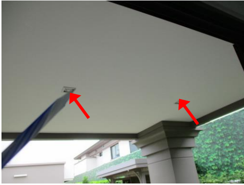
Pic:31 ทานอาหาร ดาวไลท์นอกเกลี้ยงไม่แนบทุกดวง ควรรีดให้แนบทุกดวง
