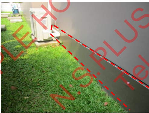
Pic:11 หลังบ้าน สีดินผนังพองรอบบ้าน ควรขัดสีเก่าออก และเก็บสีใหม่ให้เรียบร้อยทั้งหลัง
