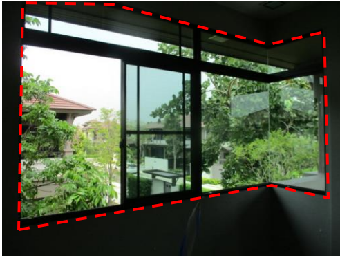
Pic:7 โถงชั้น 2 กรอบหน้าต่างมีรอยทัว และวอลเปเปอร์ไม่แนบขอบ ควรเก็บสักรอบหน้าต่าง และติวอลเปเปอร์ให้แนบขอบรอบ
