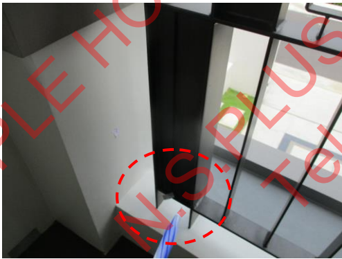
Pic:17 ระเบียงโคงชั้น 2 เหล็กเป็นสนิม ควรขัด และเก็บสีใหม่ให้เรียบร้อย
