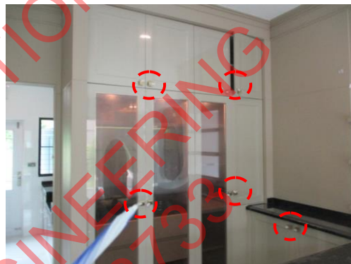
Pic:40 เตรียมอาหาร มือจับบานตู้เป็นสนิม เอียง ตรวจสอบและแก้ไขทุกจุด
