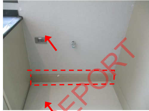
Pic:50 เตรียมอาหาร เตารับเอียง บัวไม่แนบผนัง และ กระเบื้องปิ่น ควรแก้ไข
