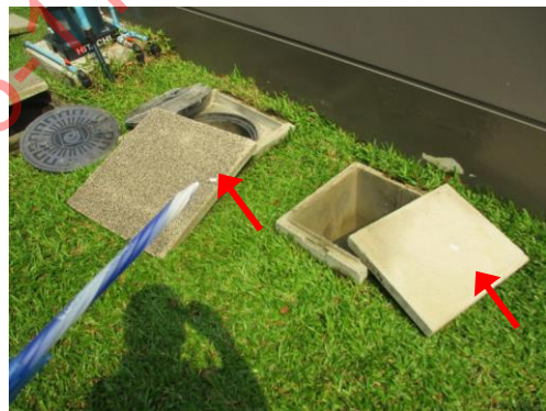
Pic:18 หลังบ้าน ฝ้าบ่อแตกร้ว หลายจุด ควรแก้ไขหรือเปลี่ยนใหม่
