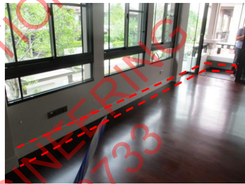
Pic:28 ห้องนอน 1 บัวอะคราบทั่ว และรอยต่อบัวไม่เรียบ ควรแต่งรอยต่อให้เรียบ และทาสีเก็บให้เรียบร้อยทั้งห้อง
