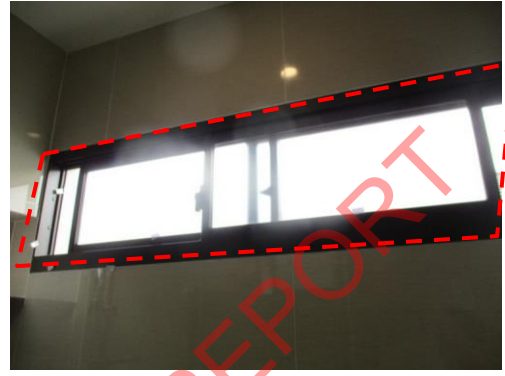
Pic: 44ห้องน้ำนอน 3 อลูมิเนียมเป็นรอยทั่ว หน้าต่างเลื่อนฝืด และขอบรอบกรอบหน้าต่างแตกควรแก้ไขเก็บสี ปรับบาน และยาแนวขอบรอบให้เรียบร้อย
