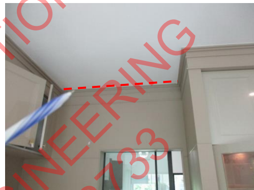
Pic:52 เตรียมอาหาร ขอบฝ้าไม่เรียบ ควรไปขัดแต่งผิวให้เรียบ และทาสีเก็บให้เรียบร้อย
