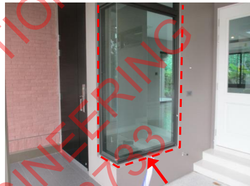
Pic:28 ซิลิโคนรอบกรอบอลูมิเนียม และมูมรอยต่อไม่ เรียบร้อย และขอบปูนบิ่น ควรแก้ไข
