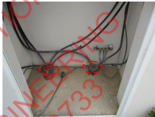
Pic:10 ท่อร้อยสายไฟ อุดท่อนไม่เต็ม ควรอุดท่อนให้เต็ม
