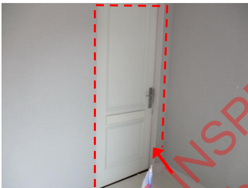
Pic:21 ห้องนอน 4 วงกบเป็นรอย และวอลเปเปอร์ไม่แนวรอบวงกบ ควรแก้ไข
