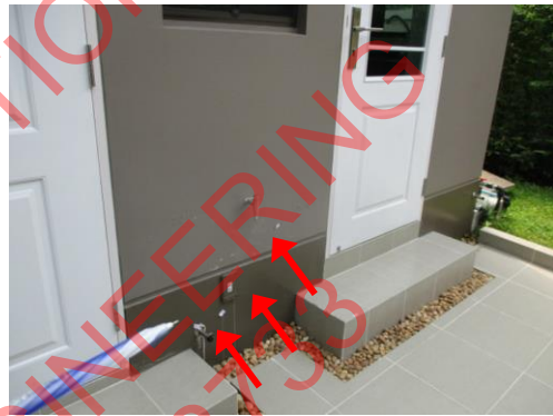
Pic:22 ช่างบ้าน ผนังสีต่าง มีคราบเกลือ และน๊อตยึดกัน กระแทก และกล่องปลวกเป็นสนิม ควรแก้ไข
