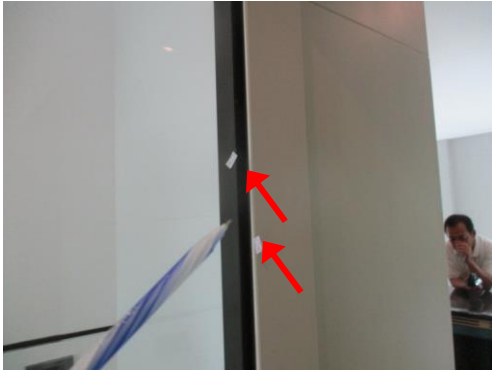
Pic:55 ครั้ว กรอบข้างประตูบีน ควรวัดแก้ไข และซิลิโคนขอบรอบให้เรียบร้อย
