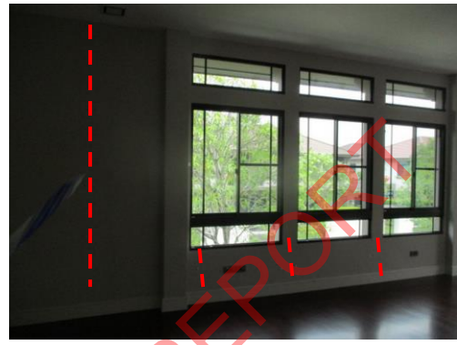
Pic:26 ห้องนอน 1 รอยต่อวอลเปเปอร์ไม่แนบทุกรอย ควรรีดให้แนบทุกรอย
