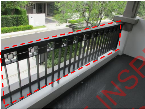
Pic:15 ระเบียงโคงชั้น 2 ราวกันตกมีคราบและ ควรทำความสะอาดให้เรียบร้อย
