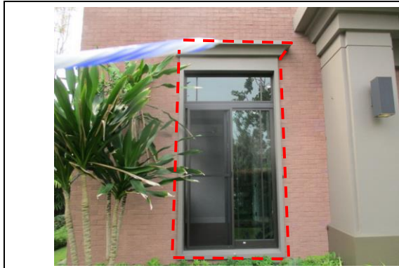
Pic:37 บั้วรอบกรอบหน้าต่างรั้วทั้ง และอลูมิเนียมเป็นรอยทั่ว ควรเก็บรอยรั้ว และเก็บสี
