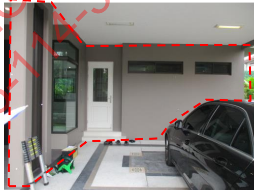
Pic:24 สีผนังต่างทุกแผง ควรเก็บสีใหม่
