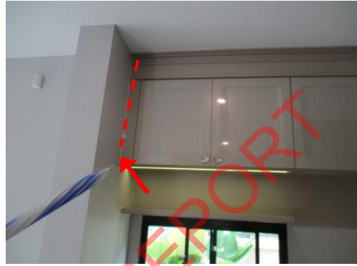
Pic:44 เตรียมอาหาร ขอบบานมีรอย และซึลิกอนขอบข้างตู้ไม่เรียบร้อย ควรเก็บสี และเก็บซึลิกอนให้เรียบร้อย
