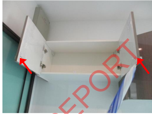
Pic:56 ครั้ว ขอบรอบน็อตยึดมีข้อจับไม่เรียบ ควรวัดแก้ไขให้เรียบร้อย
