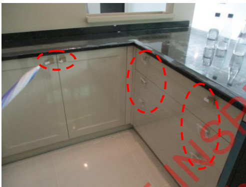
Pic:39 เตรียมอาหาร มือจับลื่นซักเป็นสนิม เอียงหลายจุด ควรตรวจสอบและแก้ไข
