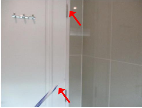
Pic:19 ห้องน้ำนอน 2 ขอบประตูสี่ล้นวงกบ และขอบรอบวงกบแตกรอบ ควรปิวเก็บรอยต่อ และเก็บสีให้เรียบร้อย
