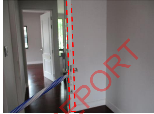
Pic:56 ห้องนอน 2 ขอบประตูแตก สีต่าง ควร โป๊วแต่งขอบประตูและทาสีใหม่
