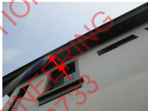
Pic:16 หลังบ้าน รอยต่อเชิงชายแตกทุกรอยต่อ ควรไปวัดแต่งรอยต่อเชิงชายทุกจุด
