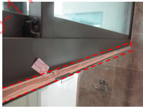
Pic:18 ห้องน้ำรวม ขาแนวได้บานเลื่อนหน้าต่างเหนือกระจกเงาไม่เรียบร้อย ควรขาแนวให้เรียบร้อย
