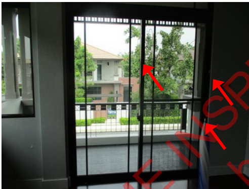
Pic:9 โถงชั้น 2 อลูมิเนียมเป็นรอย ควรเก็บสีใหม่
