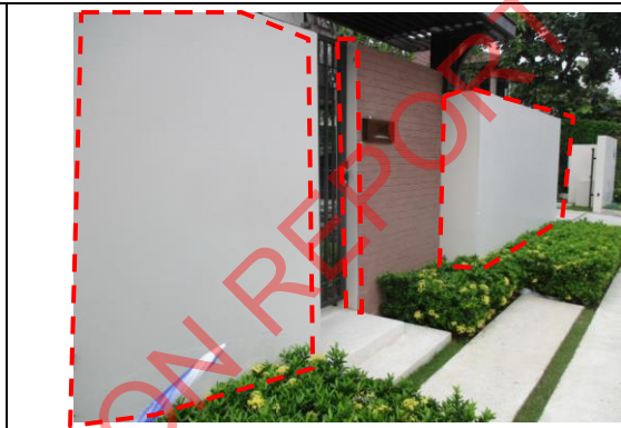
Pic:2 ผนังปูนร้าวทั่ว และรั้วเหล็กสีด่างทั้งแผง ควรโป้วเก็บสีให้เรียบร้อย
