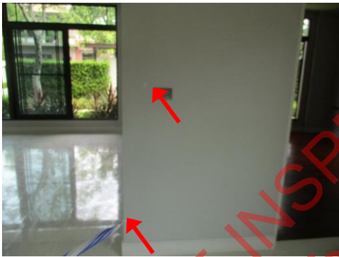
Pic:15 ห้องพักผ่อน ขอบเสาปูน และรอยต่อวอลเปเปอร์ไม้แบบ ควรแต่งขอบเสา เก็บรอยต่อวอลเปเปอร์ใหม่
