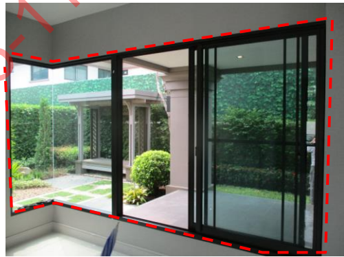
Pic:18 โถงหน้าห้องนอน 4 วอลเปเปอร์ไม้แบบกรอบอลูมิเนียม และอลูมิเนียมเป็นรอย ชิลิโคนรอยต่อไม่เรียบร้อย ควรแก้ไขรอบบาน
