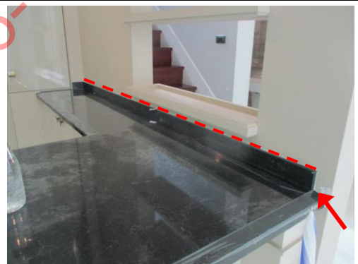
Pic:36 เตรียมอาหาร ซิลิโคนขอบหินไม่เรียบร้อย ควรซิลิโคนให้เรียบร้อยทั้งแนว
