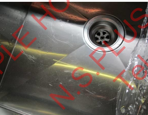
Pic:47 เตรียมอาหาร อ่างล้างงานเป็นรอย ควรทำความสะอาด หากไม่หาย ควรเปลี่ยนใหม่
