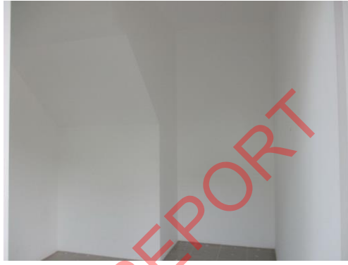
Pic:26 ห้องแม่บ้าน สีผนังต่างทุกแผง ควรเก็บสีผนังใหม่
