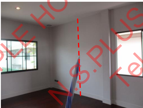
Pic:59 ห้องนอน 2 รอยต่อวอลเปเปอร์ไม่เรียบ ควรรีดให้เรียบ
