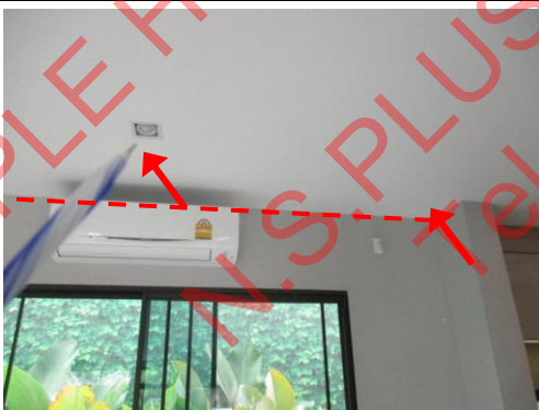
Pic:35 ทานอาหาร ฝ้ารอบโคมไฟ และขอบฝ้าไม่เรียบ ควรโป้วขัดแต่งผิวให้เรียบ และทาสีเก็บให้เรียบร้อย
