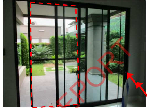
Pic:32 ทานอาหาร อลูมิเนียมบุบ และมุ้งลวดเลื่อนเสียดราง ควรถั่วแก้ไขติดตั้งใหม่
