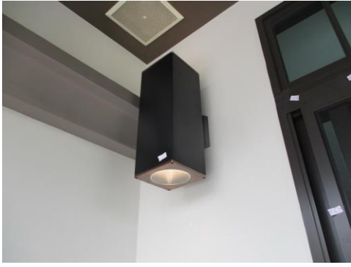
Pic:13 ระเบียงโคงชั้น 2 โคมไฟและ ควรทำความสะอาด
