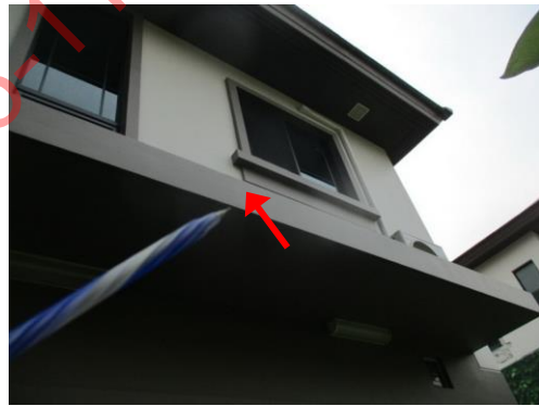
Pic:24 ช่างบ้าน ขอบพื่นกันสาดร้าว ควร โป๊วขัดแต่งผิวให้ เรียบ และทาสีเก็บให้เรียบร้อย
