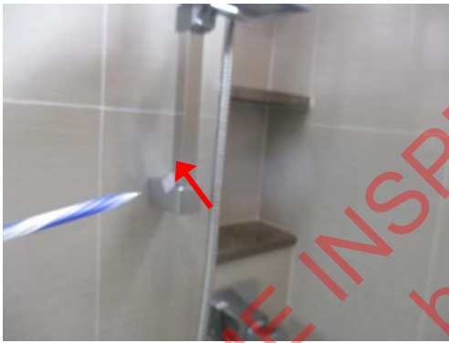
Pic: 45 ห้องน้ำนอน 3 ที่ยึดฝักบัวเป็นรอย ควรทำความสะอาด หากไม่หาย ควรเปลี่ยน
