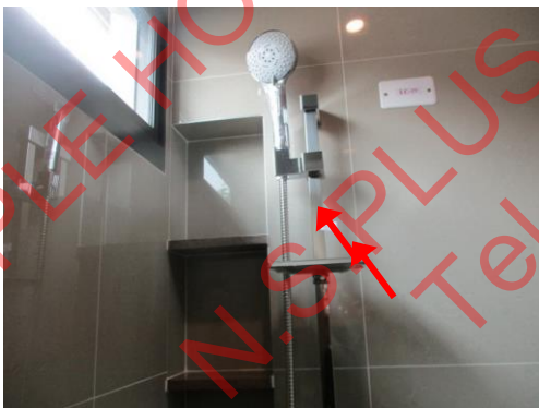
Pic:29 ห้องน้ำนอน 2 ที่แขวนฝักบัวเป็นรอย ควรทำความสะอาด หากไม่หาย ควรเปลี่ยน
