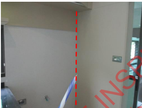
Pic:51 เตรียมอาหาร รอยต่อวอลเปเปอร์ไม่แนบ ควรรีดวอลให้แนบ
