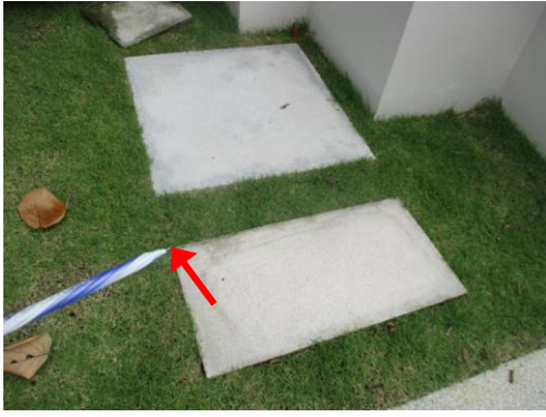
Pic:13 แผ่นหินบิ่น ควรแก้ไขหรือเปลี่ยนใหม่
