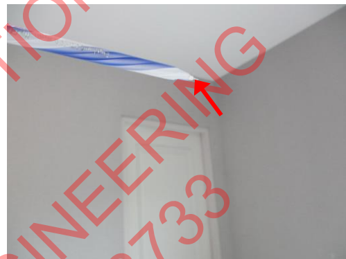
Pic:22 ห้องนอน 4 ขอบฝ้าเหนือประตูไม่เรียบ ควรโป๊วขัดแต่งผิวให้เรียบ และทาสีเก็บให้เรียบร้อย
