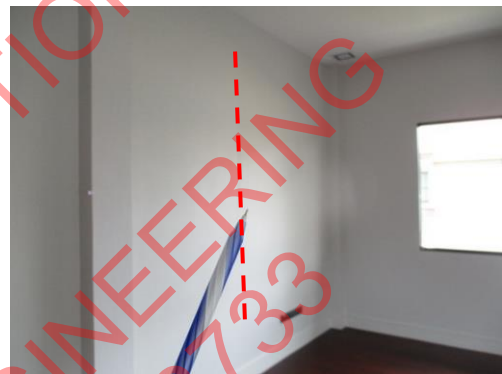
Pic:58 ห้องนอน 2 รอยต่อวอลเปเปอร์ไม่เรียบ ควรรีดให้เรียบ
