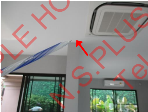
Pic:17 โถงหน้าห้องนอน 4 ขอบฝ้าเหนือเสาฝ้า ควรไขว้ขัดแต่งผิวให้เรียบ และทาสีเก็บให้เรียบร้อย
