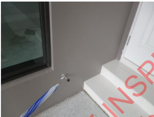
Pic:27 น็อตยึดตัวกันกระแทกเป็นสนิม ควรแก้ไขหรือเปลี่ยน น็อตใหม่
