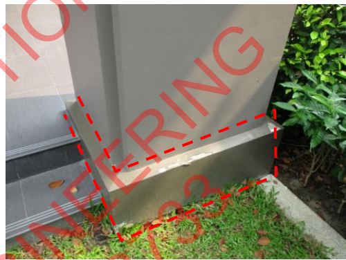
Pic:10 ช้างบ้าน สีดินเสาพอง ไม่เรียบทุกต้น ควรแก้ไขเก็บสีใหม่
