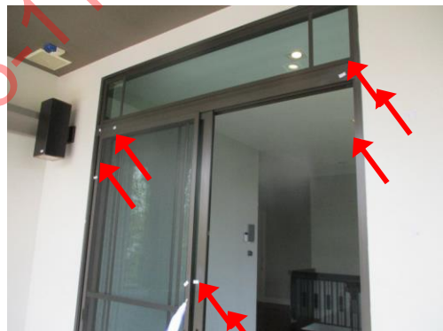
Pic:12 โถงชั้น 2 อลูมิเนียมสีต่าง ควรเก็บสีใหม่ และขอบแตกรอบ ควรโป้วแต่งขอบรอบ
