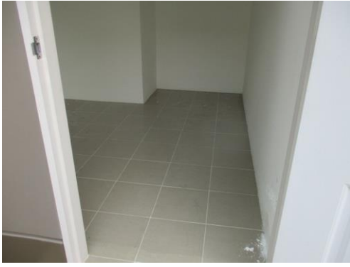
Pic:25 ห้องแม่บ้าน ขาแนวไม่เรียบร้อย ควรขาแนวให้เรียบร้อยทั้งห้อง
