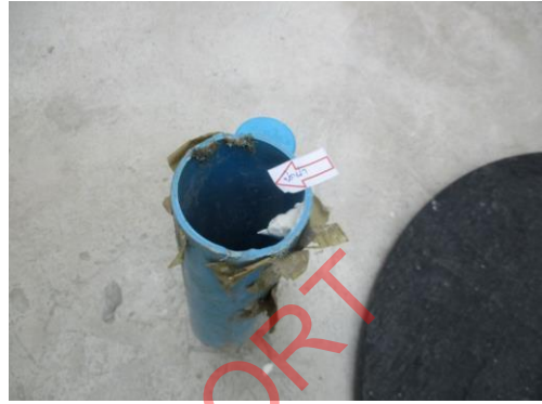
Pic:8 ท่อน้ำทิ้งเข้าถึงดักไขมัน ไม่มีฝาปิด ควรปิดฝาให้เรียบร้อย
