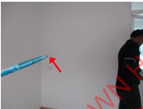
Pic:33 ห้องอเนกประสงค์ ผนังฝั่งติดห้องน้ำผิวไม่เรียบ ควรไปวัดแต่งผิวให้เรียบ และทาสีเก็บให้เรียบร้อย
