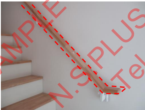
Pic:11 ราวบันไดผิวเป็นเม็ดทั้งบันได ควรขัดผิวให้เรียบ และทาสีเก็บให้เรียบร้อย
