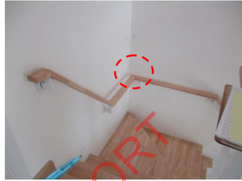
Pic:14 รอยต่อราวบันไดห่าง ควรโป้วเก็บให้เรียบร้อย
