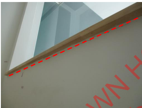
Pic:9 ขอบปูนใต้ไม้บริเวณกระจกฝ้า ควร โป้วแต่งผิวให้เรียบ และทาสีเก็บให้เรียบร้อย
