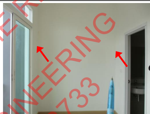
Pic:10 ห้องนอน 1 มุมผนังไม่เรียบ ควรไปขัดแต่งผิวให้เรียบ และทาสีเก็บให้เรียบร้อย
