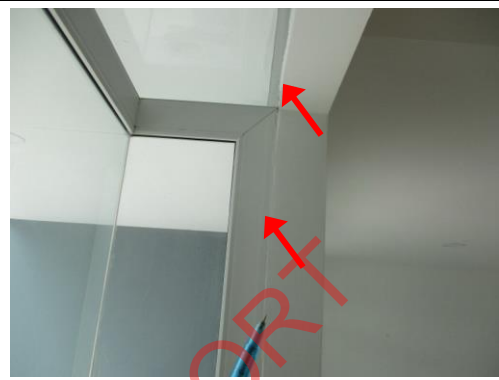
Pic:8 รอยต่อผนังปูนและหน้าต่างไม้เรียบ ควรโป้วขัดแต่งผิวให้เรียบ และทาสีเก็บให้เรียบร้อย
