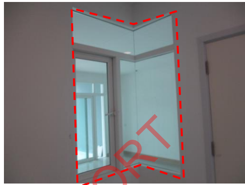
Pic:26 ห้องอเนกประสงค์ ขอบรอบกรอบหน้าต่างไม่เรียบรอบ ควรโป้วแต่งขอบรอบและทาสีเก็บให้เรียบร้อยรอบ
