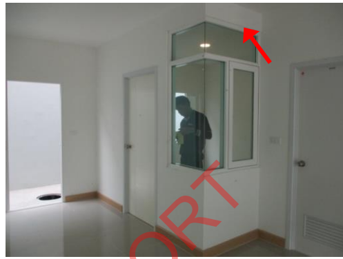
Pic:14 ห้องนอนประสงค์ ขอบปูนพื้ไม่เรียบ และไม้ ขนานหน้าต่าง ควรแก้ไขโป้วเก็บแต่งใหม่
