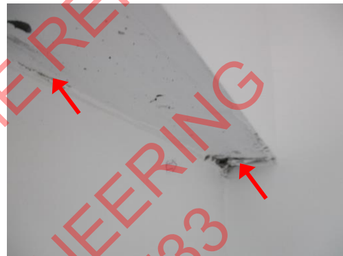
Pic:22 เก็บงานปูนในห้องเก็บของไม่เรียบร้อยหลายจุด มีรูผิวไม่เรียบ ควรโป้วแต่งรู เก็บสีให้เรียบร้อยทั้งห้อง
