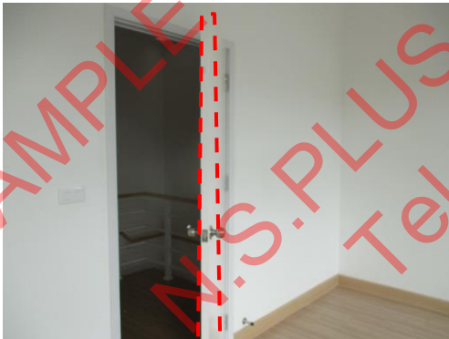
Pic:23 ขอบประตูสีต่าง ไม่เรียบทุกห้อง ควรขัดผิวขอบประตูและทาสีเก็บให้เรียบร้อยทุกห้อง
