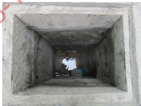
Pic:6 สภาพบ่อพักด้านหลังบ้าน ควรลอกทำความสะอาด
