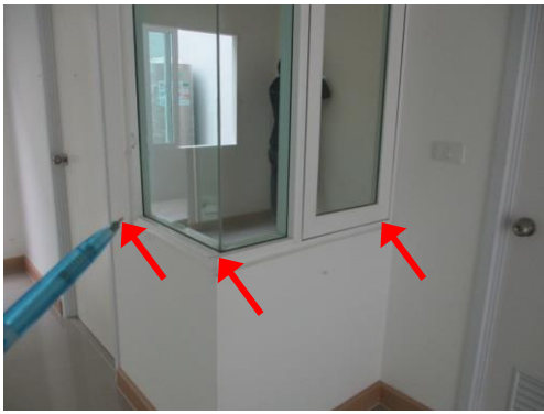
Pic:13 ห้องนอนประสงค์ ขอบปูนผิวไม่เรียบ ควรโป้วขัดแต่ง ผิวให้เรียบ และทาสีเก็บให้เรียบร้อย
