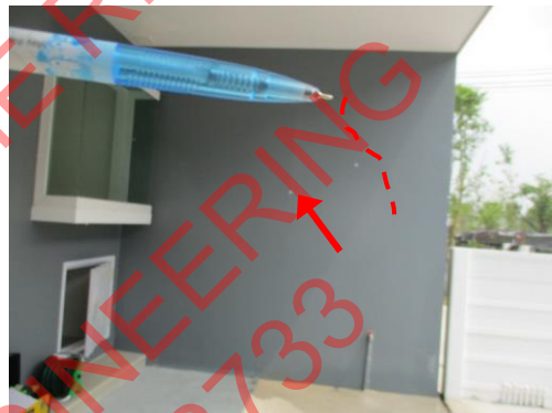
Pic:16 ผนังร้าวและปูน ควรโป้วแต่งผิวให้เรียบ และทาสีเก็บให้เรียบร้อย
