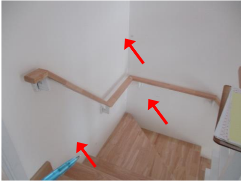
Pic:13 ผนังปูนไม่เรียบ ควรโป้วขัดแต่งผิวให้เรียบ และทาสี เก็บให้เรียบร้อย
