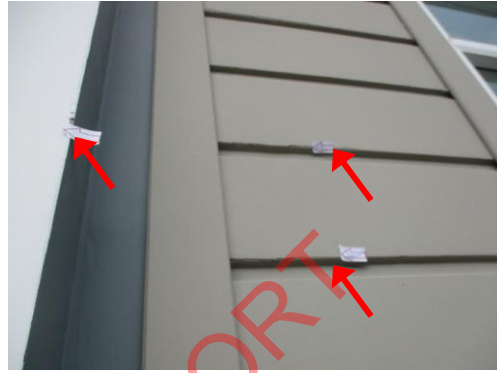
Pic:20 ระเบียงห้องนอน 1 ผนังสีน้ำตาล และสีเทานอก หน้าต่าง ข้างระเบียง ไม่เรียบ ควรโป้วแต่งผิวให้เรียบ และทาสีเก็บให้เรียบร้อย
