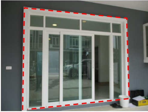
Pic:25 ขอบรอบบานเลื่อนสีแตก บัวสีต่างรอบ และมีคราบทั่ว ควร โป้วแต่งขอบรอบกรอบ และทำความสะอาดให้เรียบร้อย ทั้งบาน
