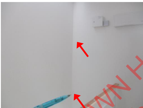
Pic:15 ผนังมุมโถงบันไดไม่เรียบ และร้าว ควรโป้วขัดแต่งผิว ให้เรียบ และทาสีเก็บให้เรียบร้อย
