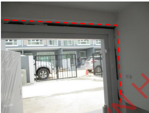
Pic:21 ขอบรอบวงกบในห้องเก็บของไม่ได้เก็บรอยต่อซิลิโคน ควรเก็บซิลิโคนรอบให้เรียบร้อย
