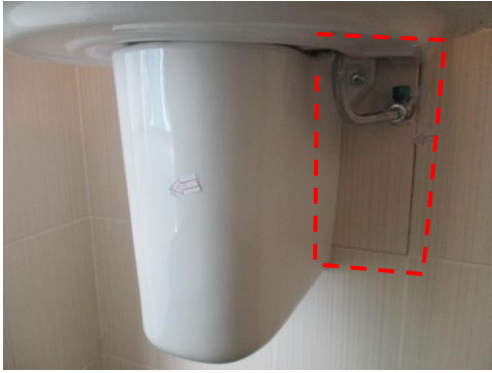
Pic:7 ขาแนวกระเบื้องด้านหลังอ่างล้างหน้าไม่เรียบร้อย ควรหาแนวให้เรียบร้อย
