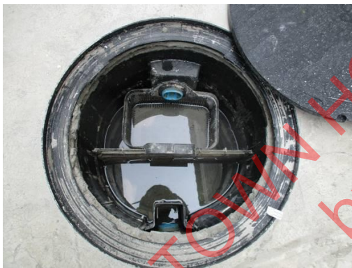
Pic:3 สภาพบ่อพักไขมัน ควรทำความสะอาดให้เรียบร้อย
