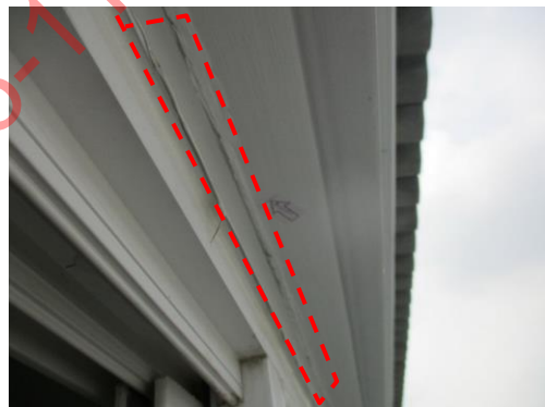
Pic:30 ห้องนอน 2 ไม้บัวเหนือหน้าต่างผิวไม่เรียบทั้งแนว ควรโป๊วแต่งผิวให้เรียบ และทาสีเก็บให้เรียบร้อยทั้งแนว
