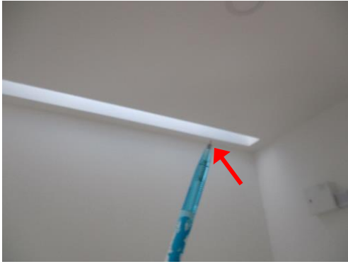
Pic:19 ขอบฝ้าช่องแสงโถงบันไดไม่เรียบ ควรปรับขัดแต่งผิวให้เรียบ และทาสีเก็บให้เรียบร้อย
