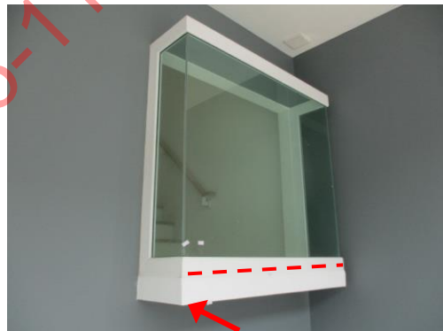
Pic:18 ขอบปูนด้านล่างเอียง ไม่ได้แนว และรอยต่อไม่เรียบร้อย ควรแต่งปูน เก็บสี และรอยต่อให้เรียบร้อย
