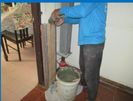
ภาพที่ 4: ภาพการติดตั้งแบบและเทคอนกรีต
