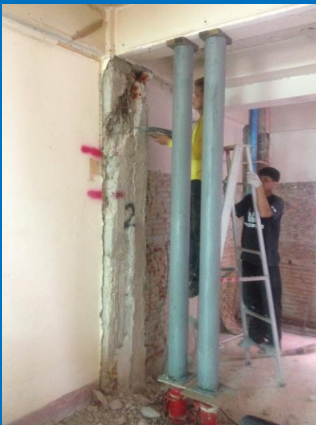
ภาพที่ 2: การติดตั้งค้ำยันโครงสร้าง
